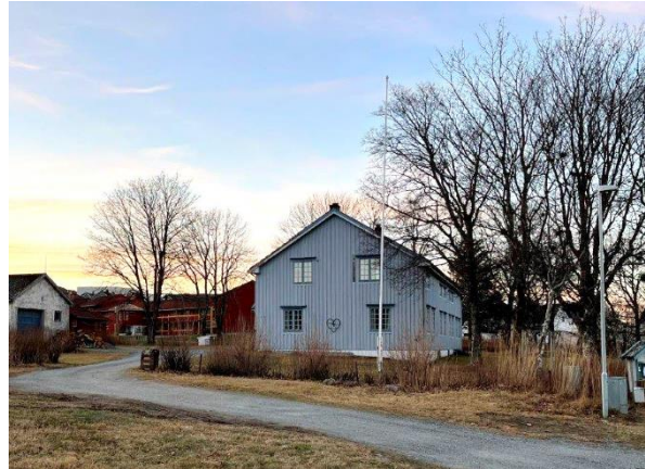
Figur 4.8.2: Presteboligen i dag. Fasade mot kirken i øst. (Foto: LINK Arkitektur)
